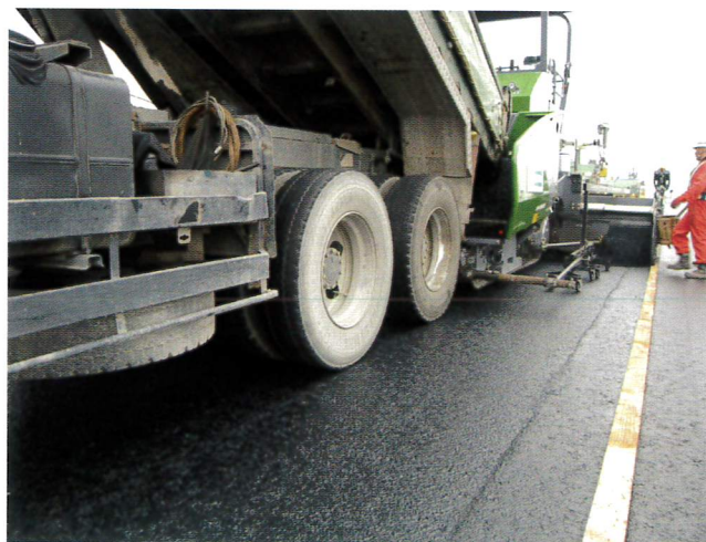
■ ダンプトラックとアスファルトフィニッシャー
